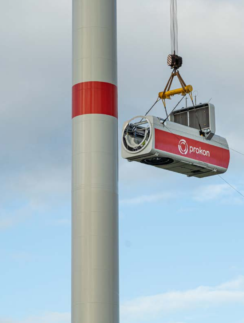
links: Gondelmontage im Windpark Ottenbüttel-Westermühlen oben rechts: Windpark Langwieden, Rheinland-Pfalz unten rechts: Photovoltaik-Anlage Emsbühen, Emsland
